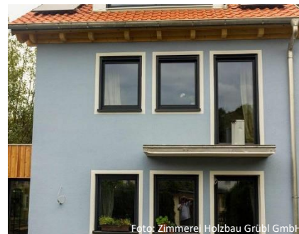
Foto: Zimmerer Holzbau Gröbl GmbH
