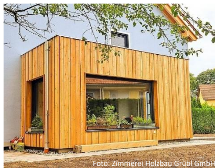
Foto: Zimmerer Holzbau Gröbl GmbH
