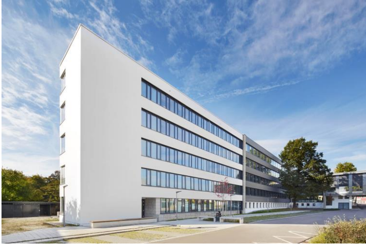
Landratsamt Dillingen, Bayern Sanierung im laufenden Betrieb TES-Fassaden, Holzrahmenbau; Erreichter Standard: KfW 55 Beteiligte: DBW ARCHITEKTEN, Gump & Maier GmbH (u.a.) Bildquelle: DBW Architekten https://www.dbw-architekten.de/beitrag-01/
