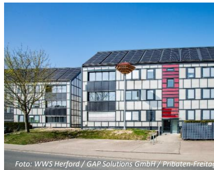
Foto: WWS Herford / GAP Solutions GmbH / Pribraten-Freitag
