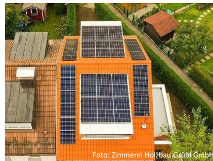
Foto: Zimmerer Holzbau Gröbl GmbH
